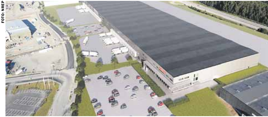
FOTO: NREP Logicenters utbyggnad på 45 000 kvm av Speeds lager på Viared i Borås är årets största logistikbygge.
