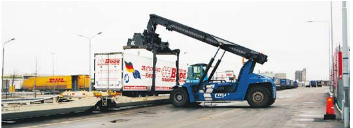
Hamnutbyggnaden i Malmö, till ett anläggningsvärde av ca 900 miljoner SEK, ska vara klar om ett år.
